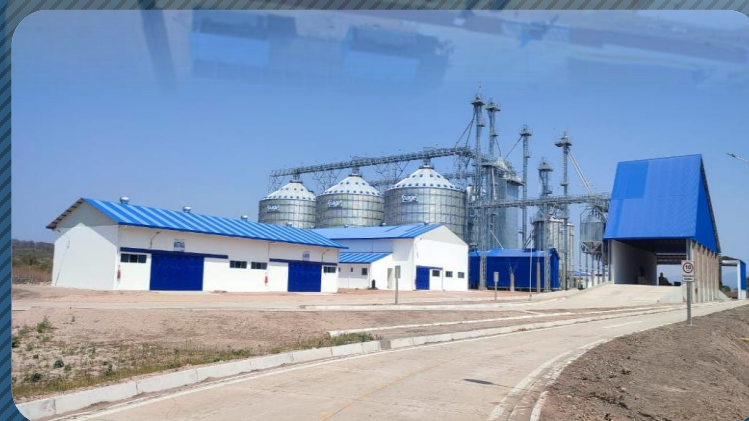
Centro de almacenamiento y transformación de granos de EMAPA municipio de Yacuiba. Monto con D.S. : 122,5 millones de Bolivianos
