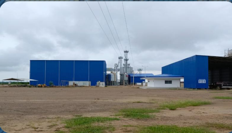
Industria de cárnicos en el Beni Monto con D.S. : 294,8 millones de Bolivianos Centro de Confinamiento
