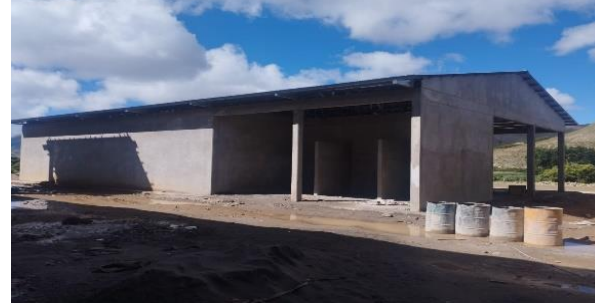
BLOQUE DE MANTENIMIENTO
