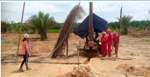
PERFORACION POZO DE AGUA
