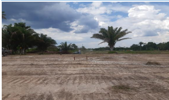
CONFORMACION DE TERRAPLEN
