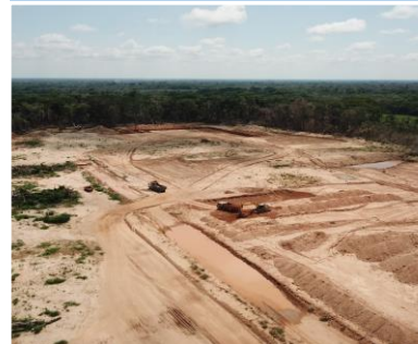
CONFORMACIÓN PLATAFORMA
