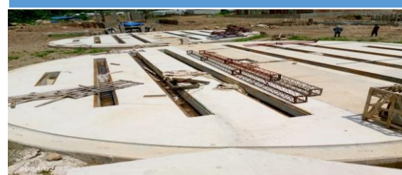
BASE DE SILOS ARROZ 8tn.
