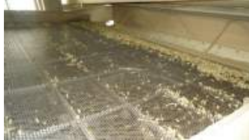
Figura 1.39: Una de las zarandas de la máquina de limpieza (Planta EMAPA, Cuatro Cañadas)
